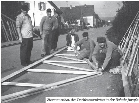
Zusammenbau der Dachkonstruktion in der Bahnhofstraße
