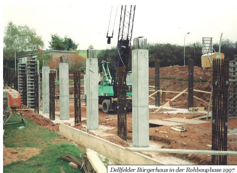
Dellfelder Bürgerhaus in der Rohbauphase 1997
