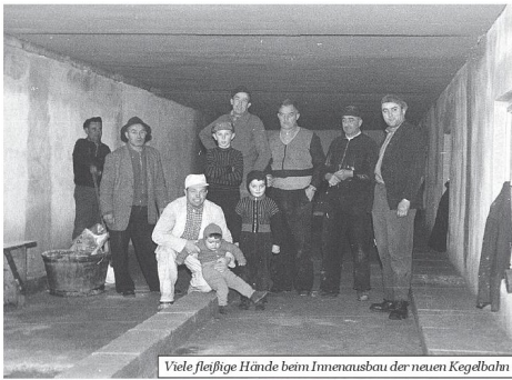
Viele fleißige Hände beim Innenausbau der neuen Kegelbahn
