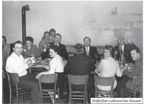
Helferfest während der Bauzeit
